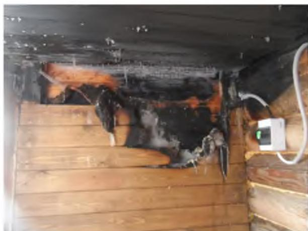
Так, ночью 07 декабря в с. Новопятницкое, в результате короткого замыкания электрической проводки, привело к возникновению пожара в надворных постройках. Случившееся стало возможным в результате халатного отношения собственника усадьбы, так как электрическая проводка находилась в ветхом состоянии и требовала замены.
