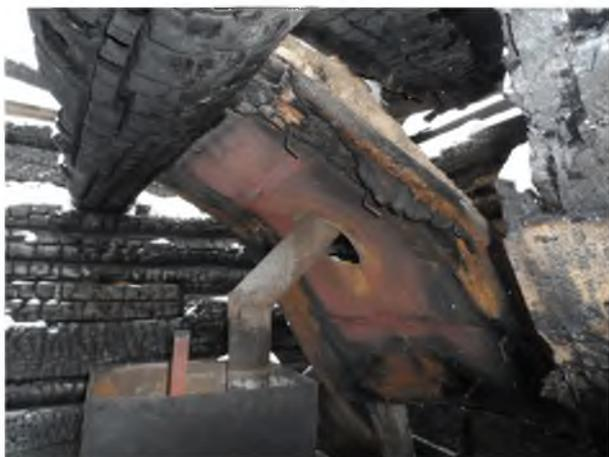
В ночь с 12 на 13 декабря в с. Новопятницком в бане, расположенной на территории жилой усадьбы произошел пожар. Причиной пожара послужило отсутствие разделки трубы дымохода, в результате перекала металлической трубы дымохода, произошло нагревание и последующее воспламенение деревянных конструкций потолочного перекрытия.
